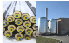
Zwei 50 m³ Wärmespeicher, 5,5 km Nahwärmenetz für 145 Haushalte
