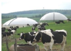
3000 m³ Fermenter / 5000 m³ Lager
