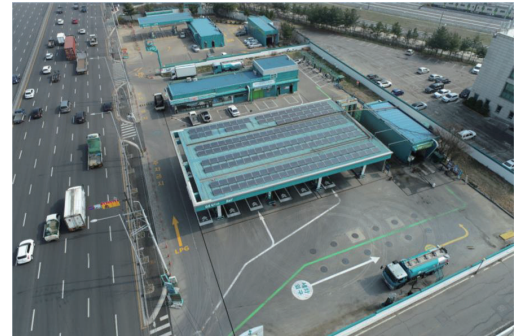
정왕IC주유소 태양광패널 설치
