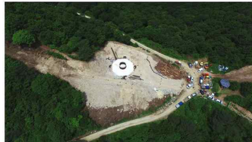
의령 풍무산 5만 풍력발전기 공사 현장 ©경매포
