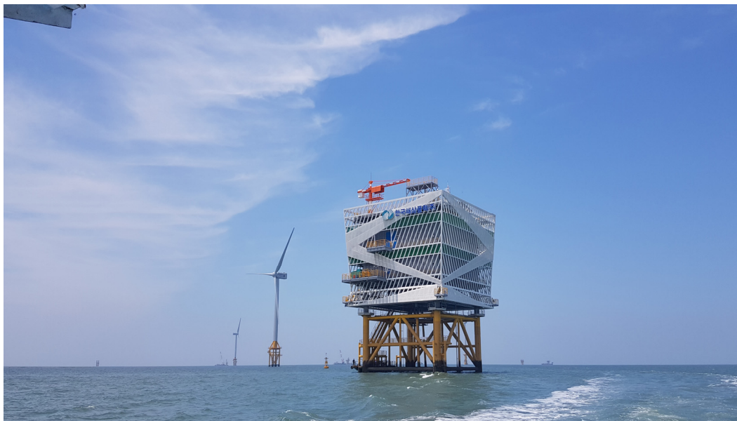
(서남해 해상풍력발전단지 발전기 및 해상변전소 설치전경)
